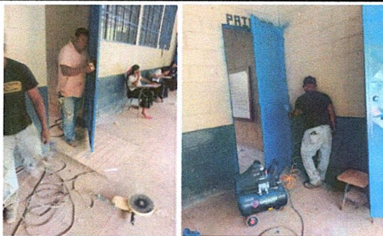
Foto 3: Reparación de puertas, colocación de chapas y la pintada.
