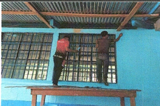
Foto1: Aplicación de pintura de paredes exteriores.
