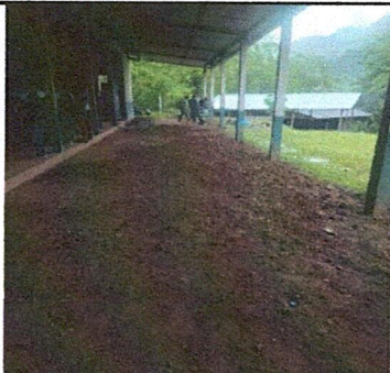
Foto 5: Nivelación de la tierra para la sustición del piso de concreto.
